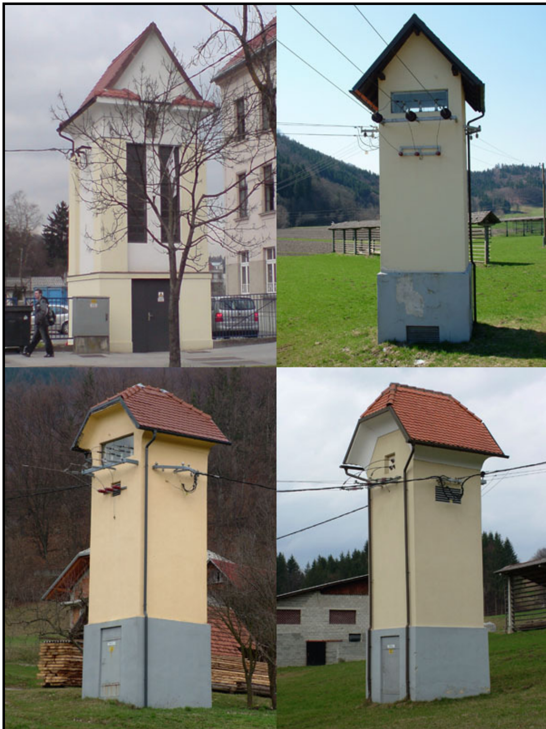
Nekaj primerov transformatorskih postaj po Sloveniji
