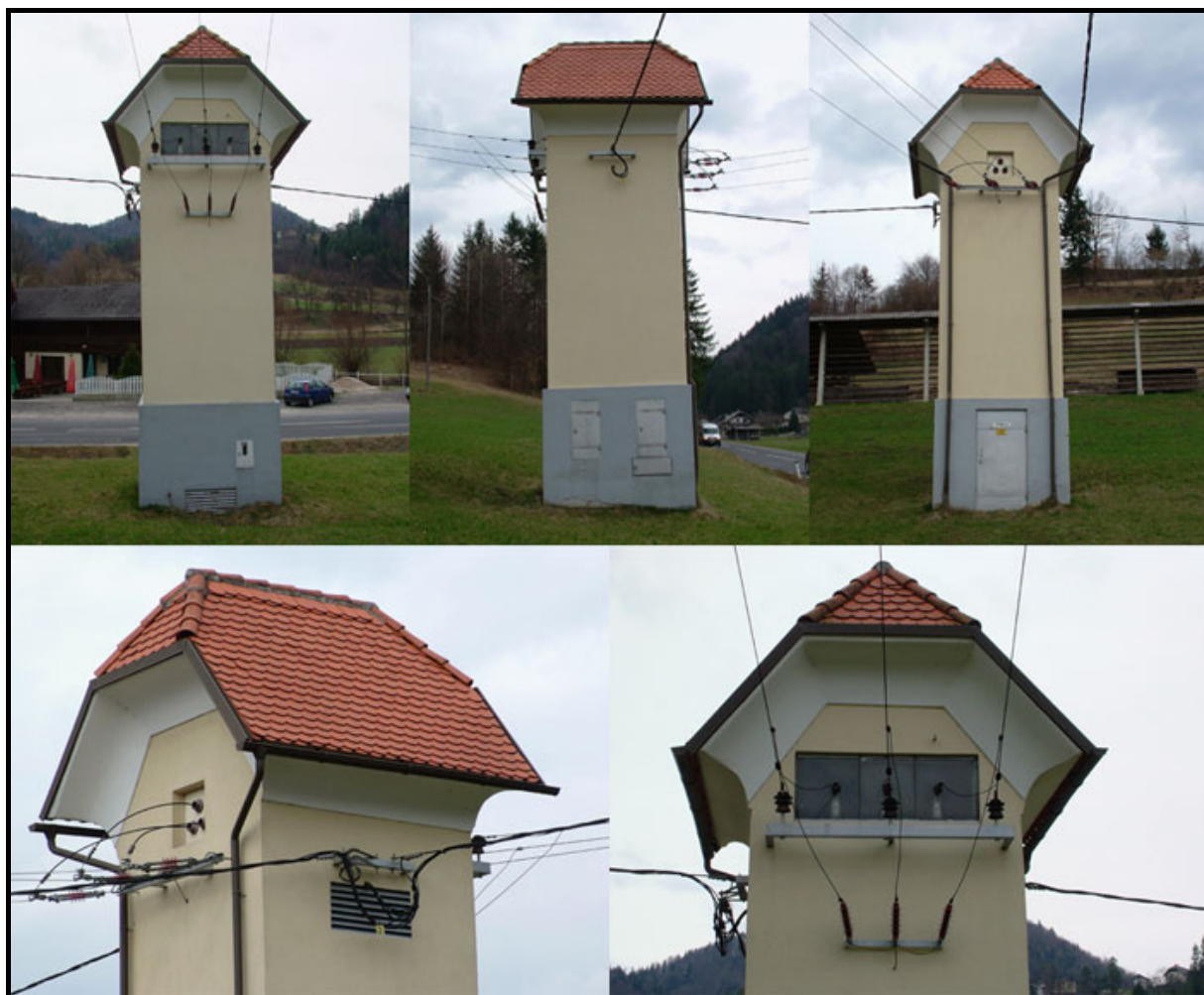
Primer transformatorske postaje Kranjske deželne elektro družbe
